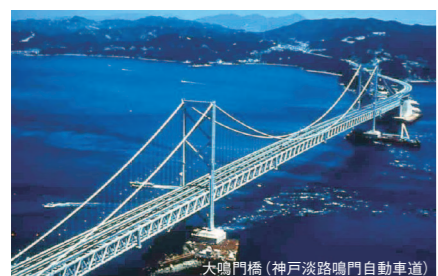
大門橋 (神戸淡路鳴門自動車道)
