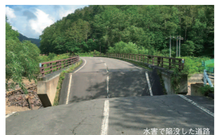
水害で陥没した道路
